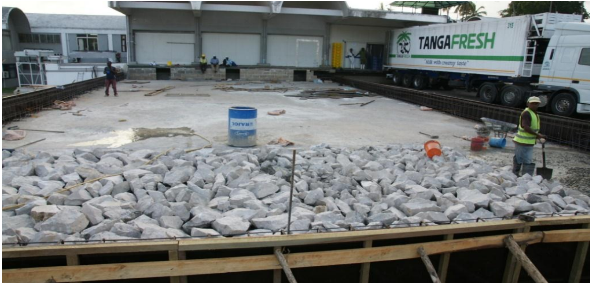
Ujenziwa jengo jipya wa Kiwanda cha Tanga Fresh ukiendelea, Januari 2017
