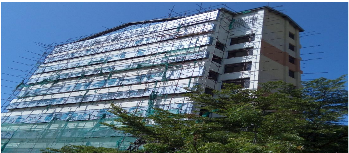
Hatua ya ujenzi wa Jengo la "DIT Teaching Tower Complex" Februari, 2017
